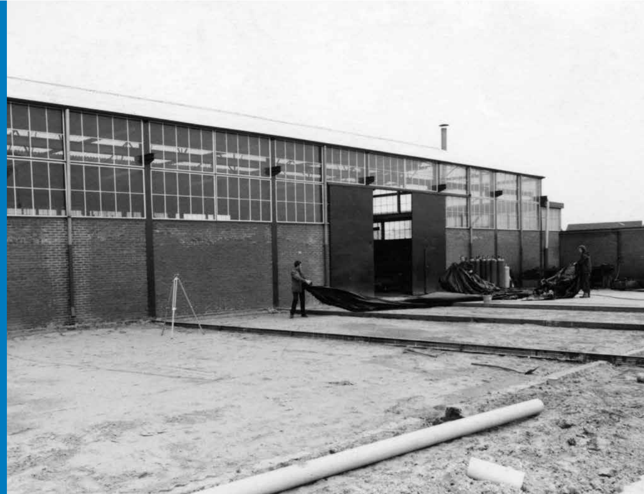
GRONDWERKZAAMHEDEN VOOR DE BOUW VAN HAL 2
