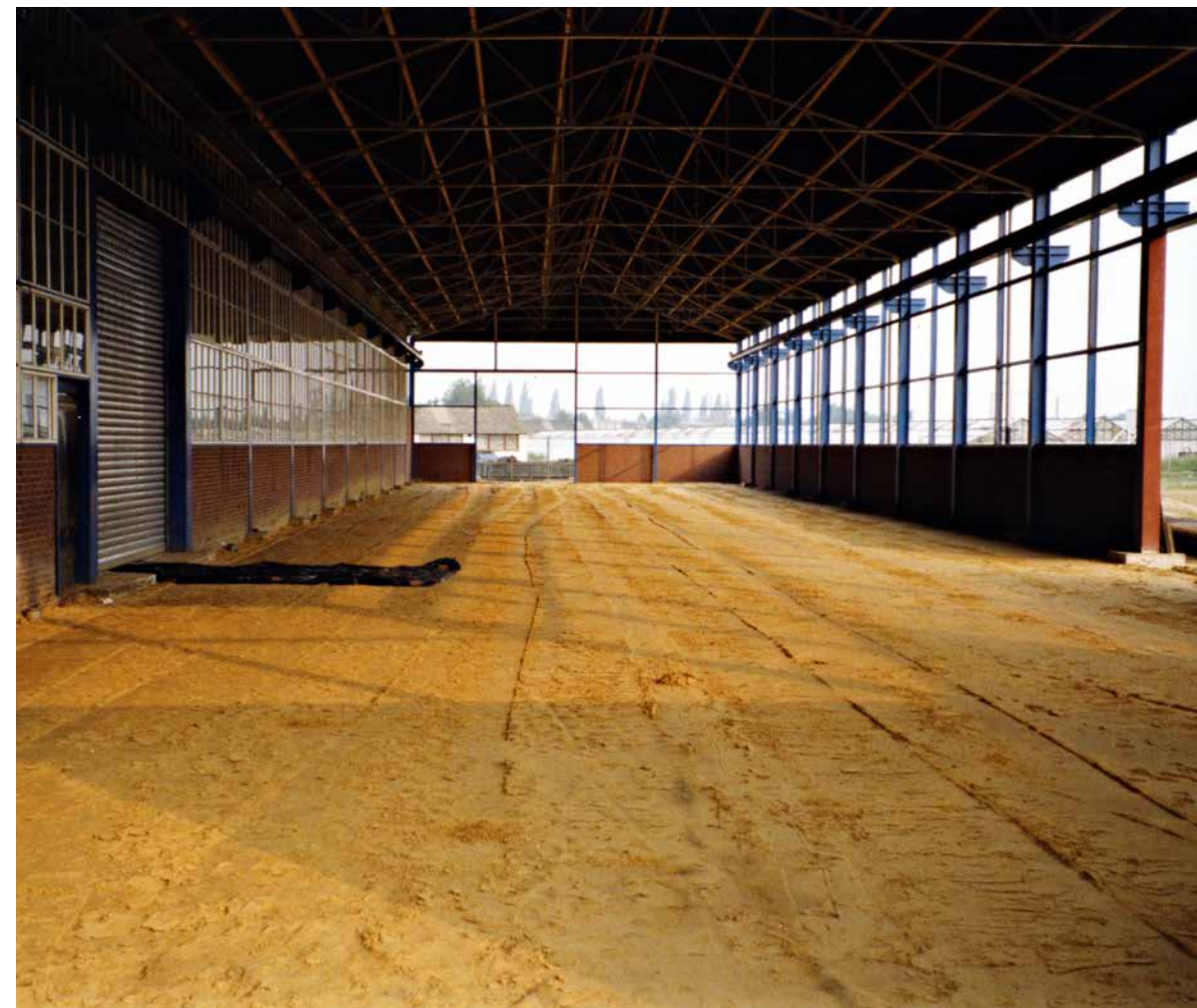
BIJZONDER WAS HET STORTEN VAN DE VLOER
